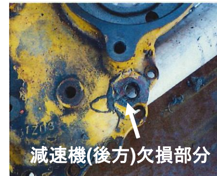
後方レベルゲージ管接続部
