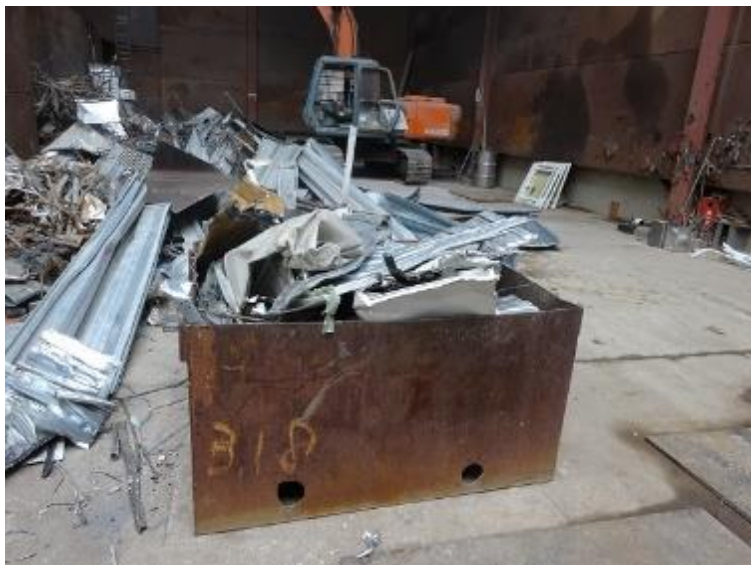
減容処理設備で切断した金属瓦礫のイメージ
