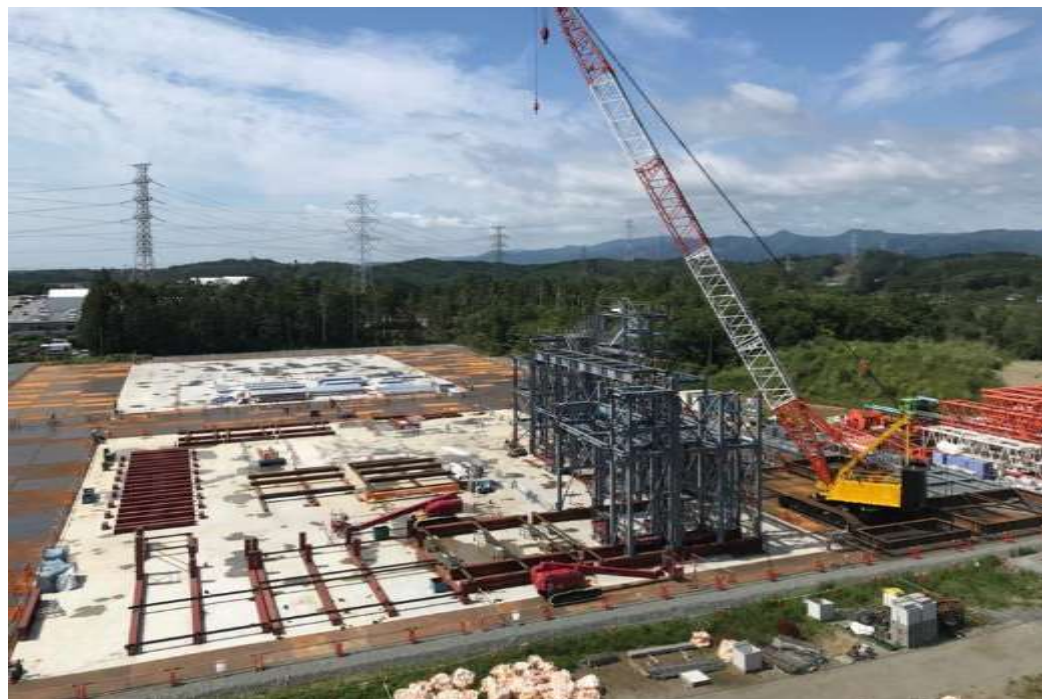
構外ヤード全景（2021年6月21日時点）
