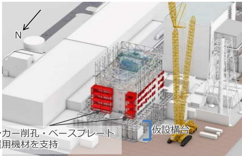
アンカー削孔、ベースプレート設置中
