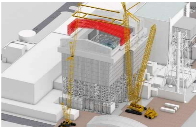
可動屋根設置中
