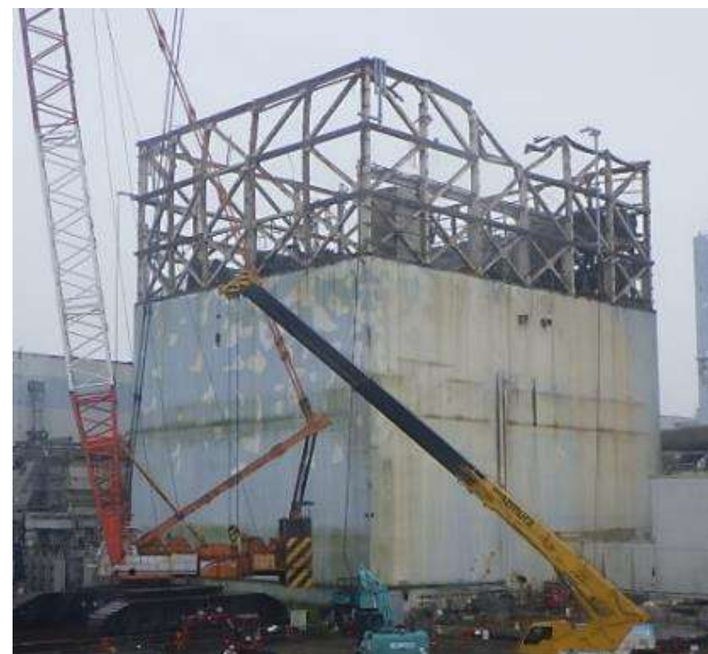
1号機原子炉建屋全景（2021年6月19日時点）
