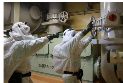
排気経路の遮断 (ダンパ閉止作業)
