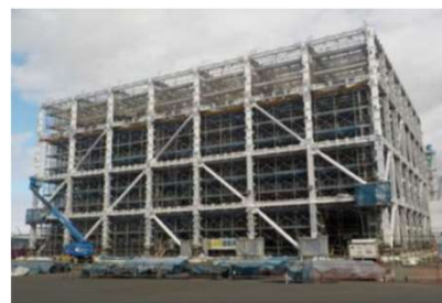
防護ネットの設置状況 (2021年10月現在)
