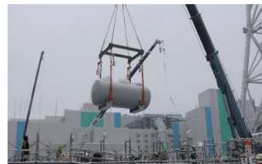
薬品貯槽を大型クレーンで地下8mにある設置場所へ据付(2021年2月撮影)
