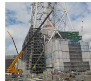
防護板の設置状況 (2021年10月現在)
