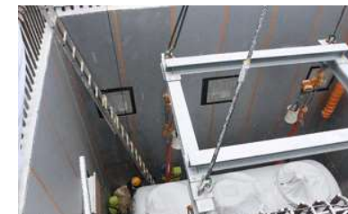
薬品貯槽を大型クレーンで地下8mにある設置場所へ据付(2021年2月撮影)
