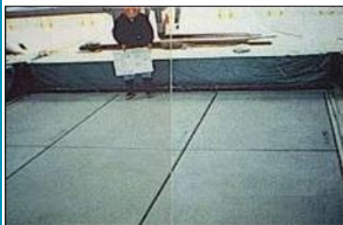
上部ポーラスコンクリート設置
