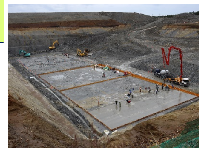
3号の工事の様子
