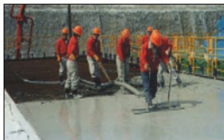
覆い(鉄筋コンクリート)を打設
