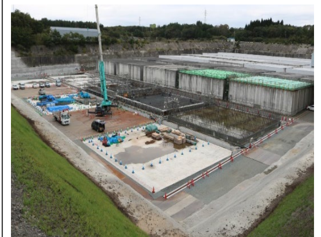
1号7、8群の工事の様子
