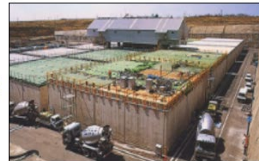
セメント系充填材(モルタル)注入
