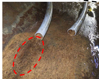
湧水箇所 (導水パイプ)
