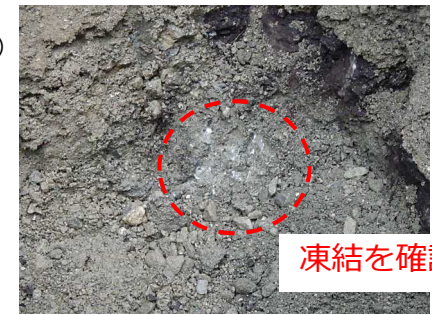
掘削した土 (固結状態) (測定箇所①G.L.-1.3m付近)
