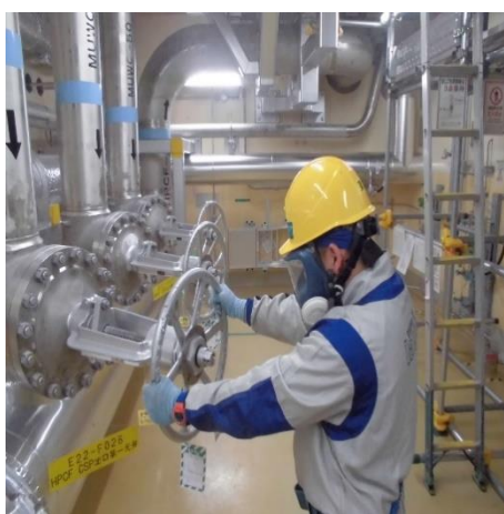
復水貯蔵槽出口ライン隔離
