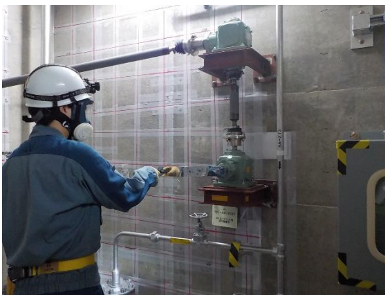
系統構成（遠隔手動弁操作設備）
