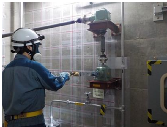
ベント操作（遠隔手動弁操作設備）
