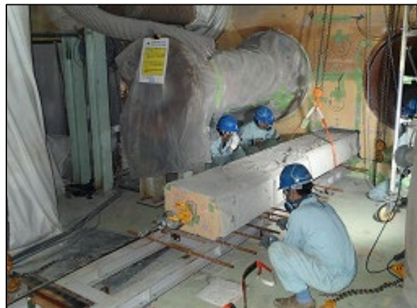
コンクリートブロックの引抜き
