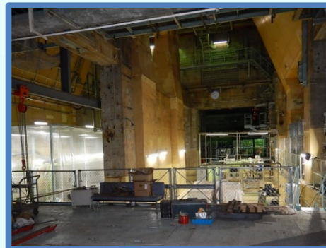
復水器解体撤去後 (2018. 3. 23)
