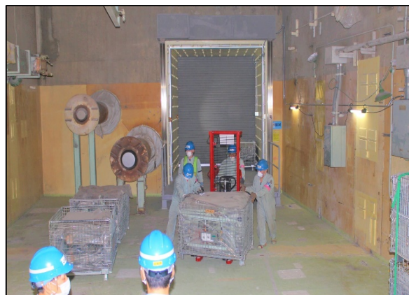
運用開始 (解体撤去物の搬出)
