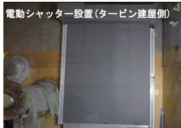
シャッター設置完了
