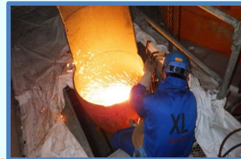
高圧タービン排気配管の切断 (2017. 6. 23)
