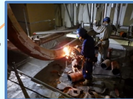
主蒸気管 (高圧タービン入口配管) の切断 (2017. 7. 28)
