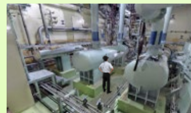
解体手順の確認・検討
