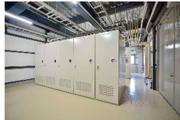
電気室(受変電設備)(1階)
