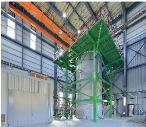
モックアップ試験室(クレーン設備)
