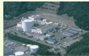
「ふげん」等建屋内 レーザー計測データ
