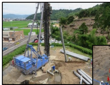
水中クワ基礎工事 (杭打ち工事7/3~14)
