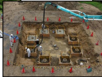
水中クワ基礎工事 (配筋・コンクリート打設)
