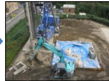
建物工事 (杭打ち9/26~10/7)
