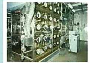
グローブボックス等多数の不稼働設備
