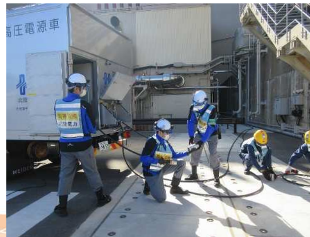
美浜発電所（10/29） 事故収束訓練（北陸電力高圧電源車）
