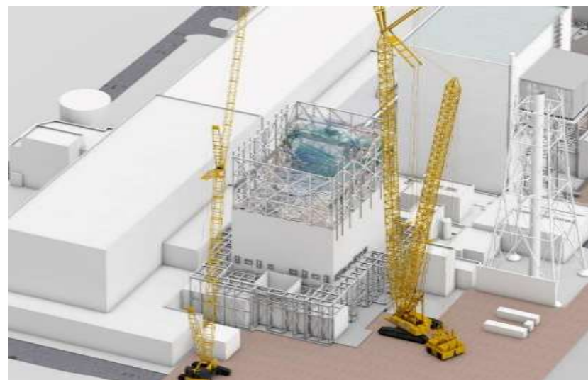
仮設構台設置完了
