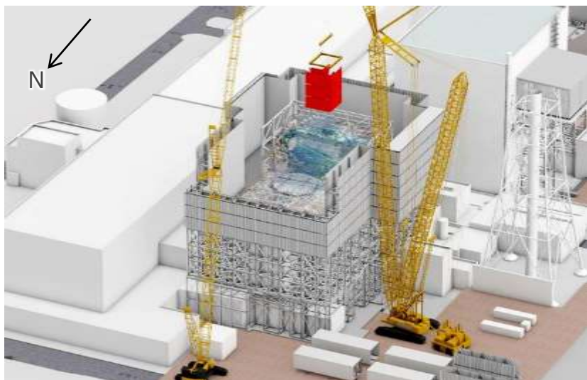
上部架構設置中
