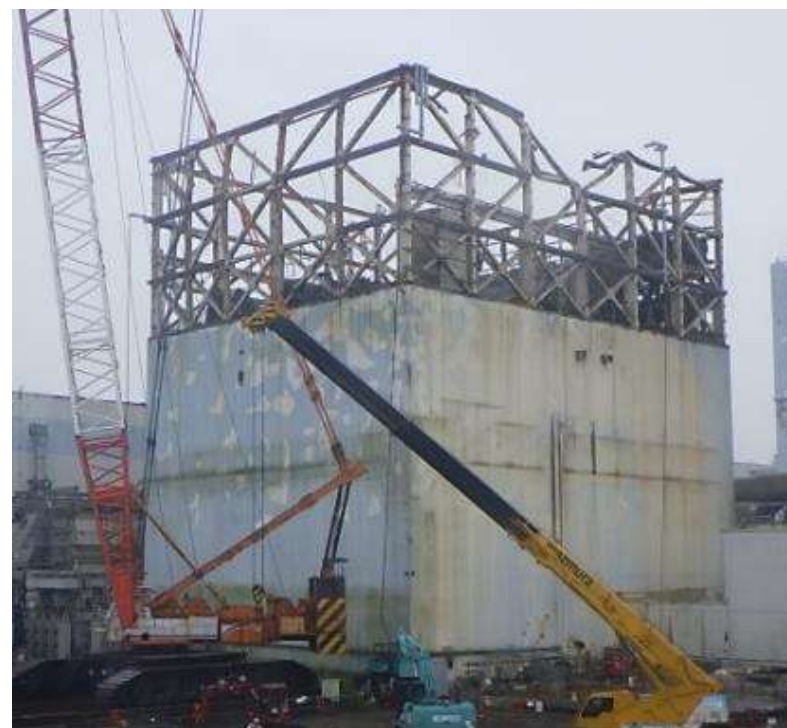
1号機原子炉建屋全景（2021年6月19日時点）
