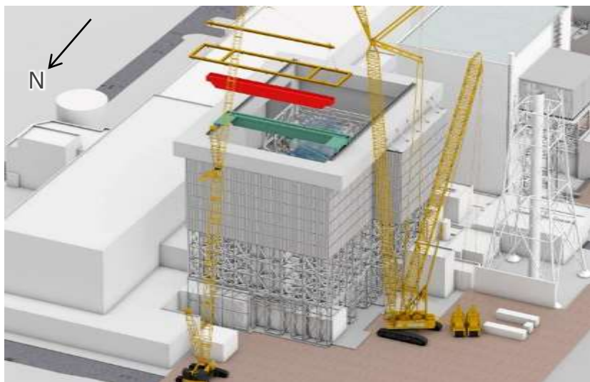
ガレキ撤去用天井クレーン設置中
