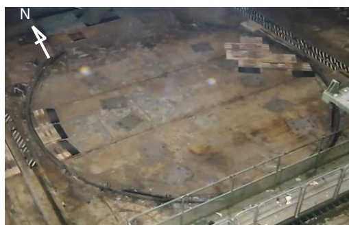
現場状況写真
