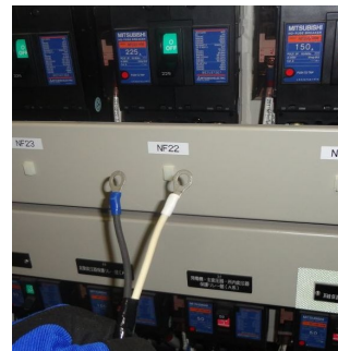
【直流き電盤内NFB2次側へ接続】
