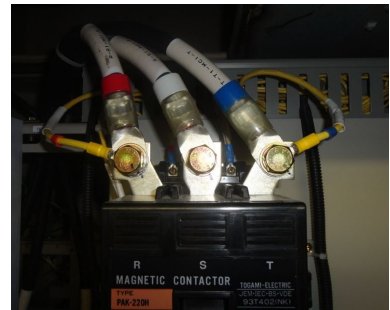
【直流き電盤内NFB2次側へ接続】
