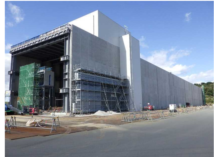
建屋本体工事状況（10月21日撮影）
