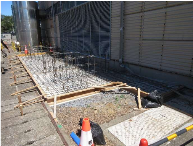
基礎部鉄筋、型枠 (R3. 8. 20)
