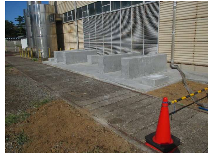
立上り基礎部完成 (R3. 9. 29)
