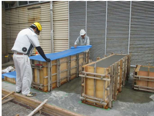
立上り基礎部コンクリート打設 (R3. 8. 31)
