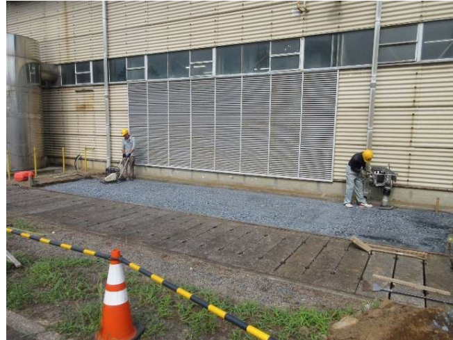
砕石敷き、転圧 (R3. 7. 29)
