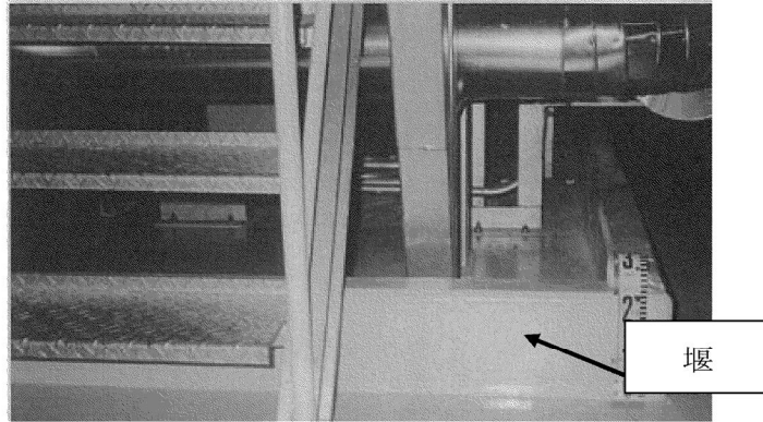
第 1-2 図 堰による拡大防止対策の例
