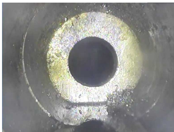
ペネ孔径拡大前 (孔径φ50)
