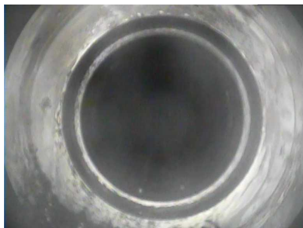
ペネ孔径拡大後 (孔径φ130)
