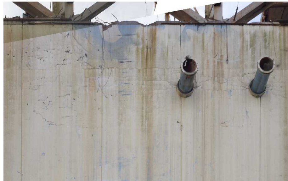
撮影した写真画像の一例（西面）
