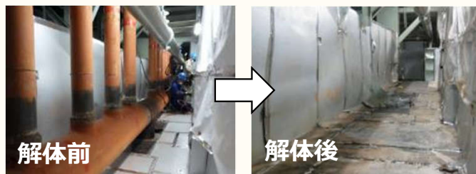
蒸気ヘッド⇒2021年度解体実施
