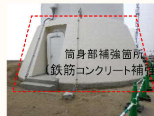
第二付属排気筒の耐震補強
