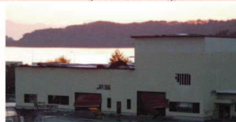
建屋壁材の剥がれ状況
