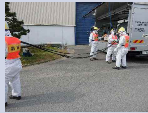
ケーブル搭載車からケーブル取出・敷設
