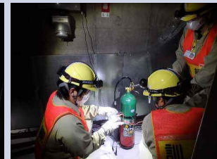
電気室内パワーセンター仮設ケーブル敷設
