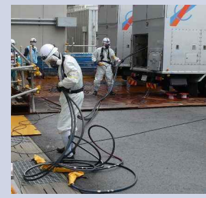
ケーブル敷設
