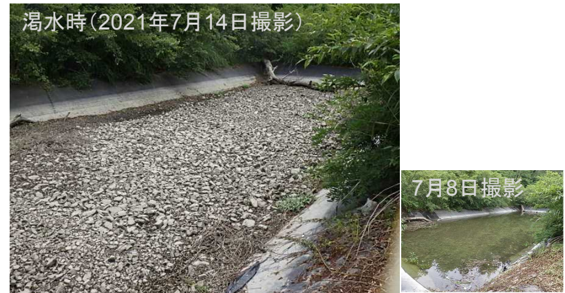
図4 沈砂池全景写真 (測定箇所x1近傍からx30方向を撮影)
