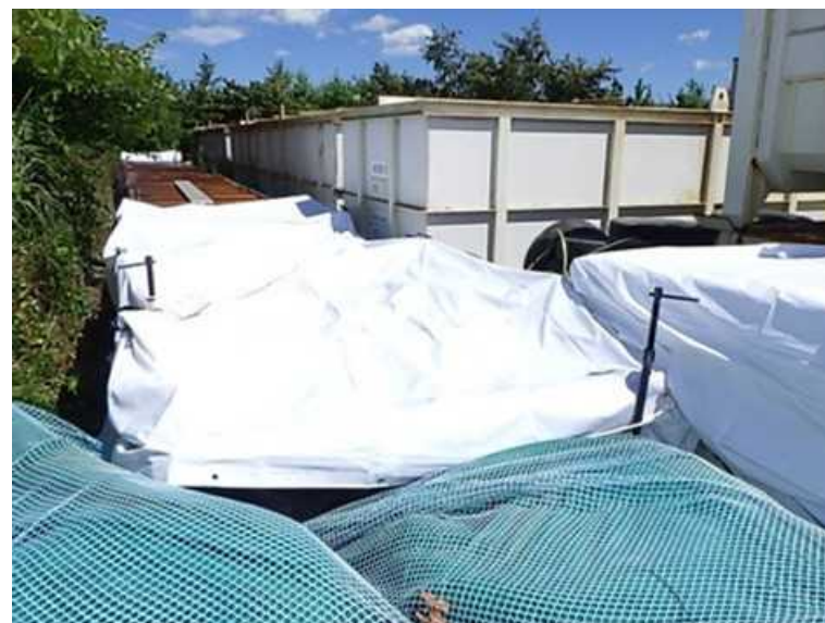
シート養生後
