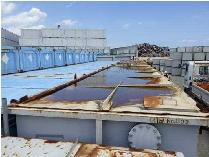
ノッチタンク上部の状況 (2021.7.6撮影)
