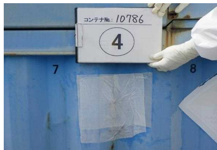
写真8.写真7のコンテナの補修後 (5月3日補修,5月3日撮影)
