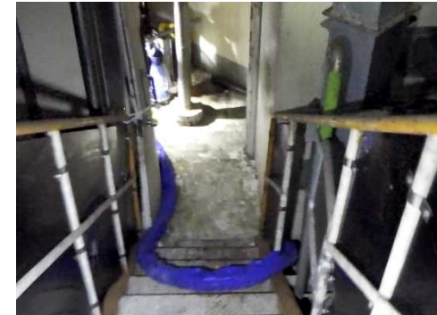
トラス室内仮設排水設備布設状況
