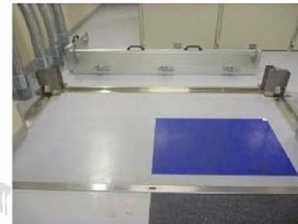
堰の設置例（浸水防止設備技術指針JEAG 4630-20XX（公衆審査版））
