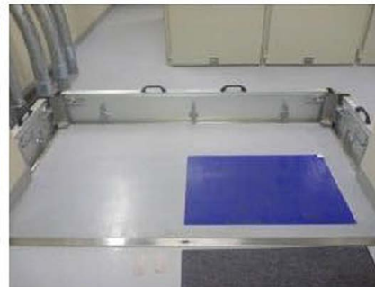
堰の設置例（浸水防止設備技術指針JEAG 4630-20XX（公衆審査版））
