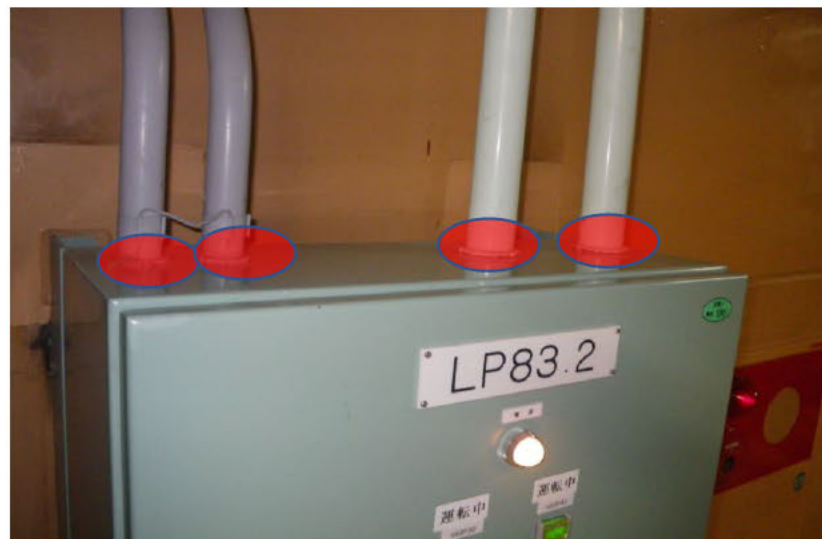
シール処置概要（電線管接続部へのシール処置の例）
