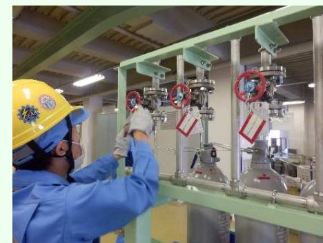
窒素ガスポンベ交換訓練
