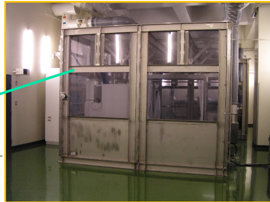
第2UWSF 詰替室 パネルハウス
