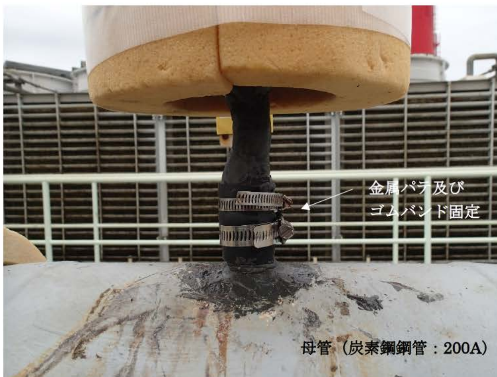
写真3 金属パテ等による処置
