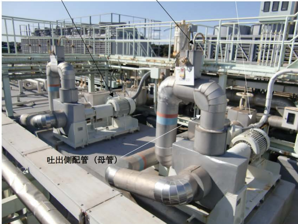
写真1 2次冷却水設備 (B 系統) の冷却水ポンプや配管等
