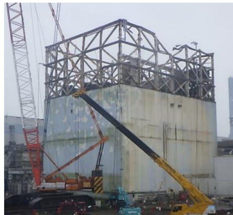
1号機原子炉建屋全景（2021年6月19日時点）
