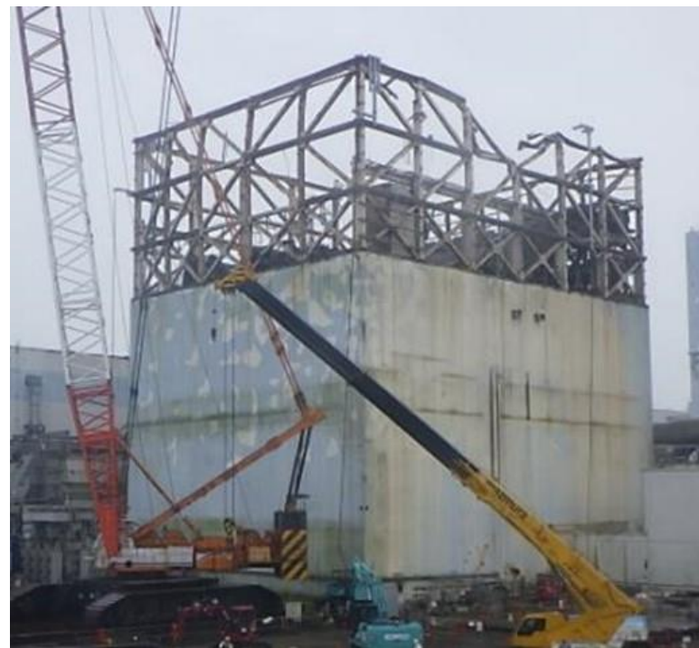
1号機原子炉建屋全景 (2021年6月19日時点)
