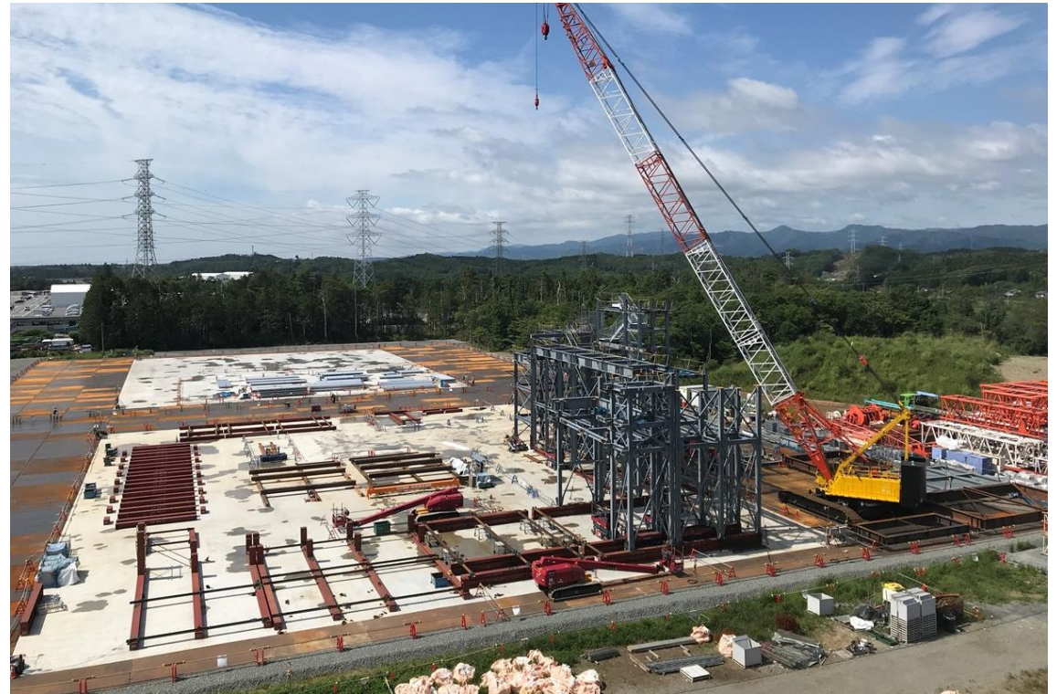
構外ヤード全景 (2021年6月21日時点)
