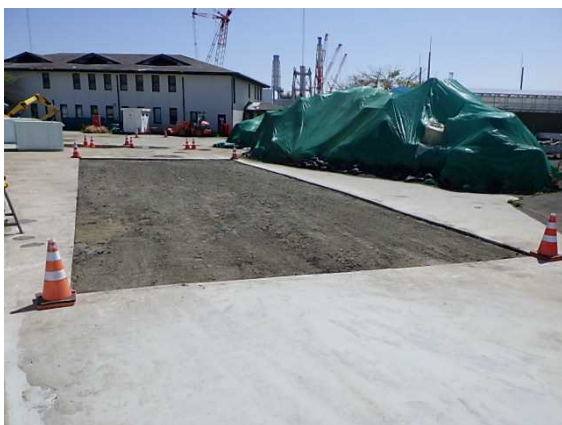
アスファルト舗装はぎ取り（4月15日） （70 \mu m線量当量率が高い箇所）
