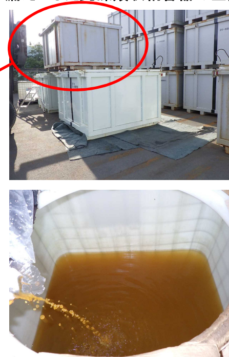
水が漏れ出した瓦礫類収納容器の全景
