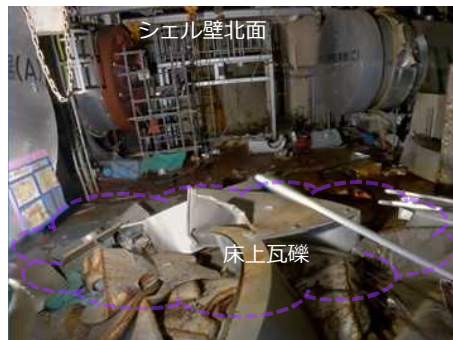
写真2D: シェル壁北面と北側床上瓦礫の状況
