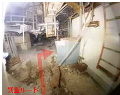
写真3B: プール壁の南西部
