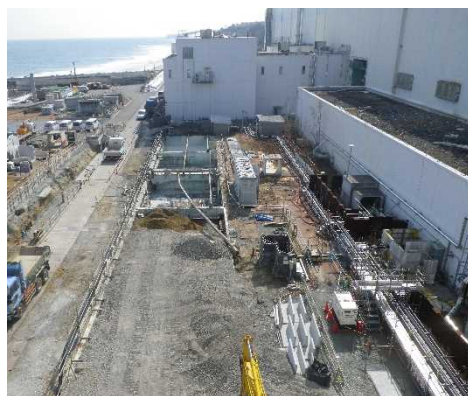
クレーンヤード整備状況【整備中】 〔北側から撮影〕
