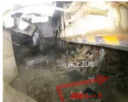
写真3C: プール壁とハッチ開口の間
