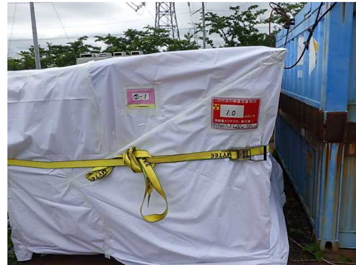
コンテナ養生・線量表示実施後
