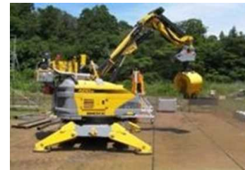
使用する遠隔操作重機 (BROKK400D)
