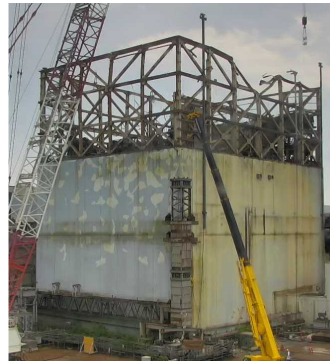
1号機原子炉建屋全景（2021年5月24日時点）
