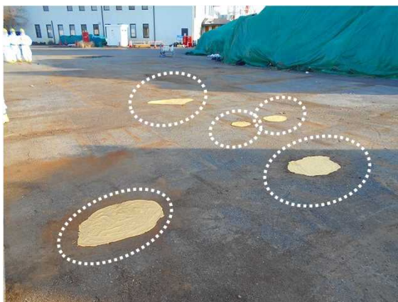
堆積物除去・除染材塗布後（3月24日）
