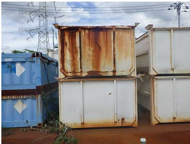
コンテナ(福島県職員情報) 表面線量0.48mSv/h、側面腐食
