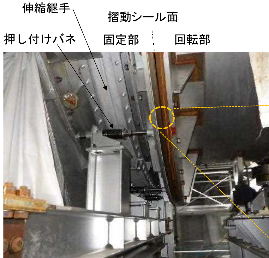
ロータリーキルン シール部(入口側)
