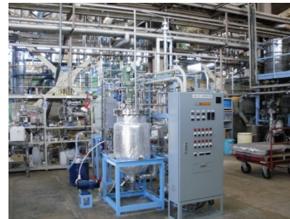
図 工学規模試験装置
