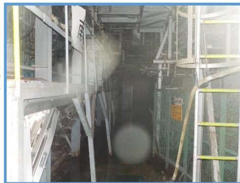
原子炉建屋1階の重要設備及び搬入経路確保に伴う干渉物写真
