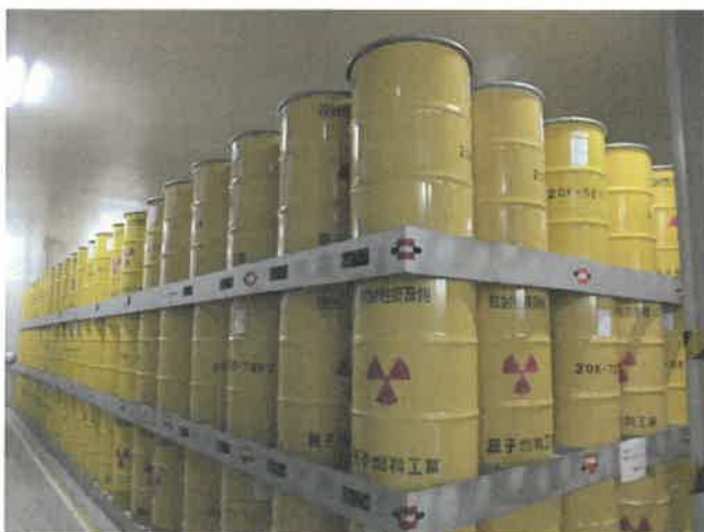
3段積みのドラム缶保管状況の例
