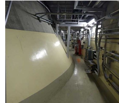
参考写真: シェル壁東面(5号機2階)
