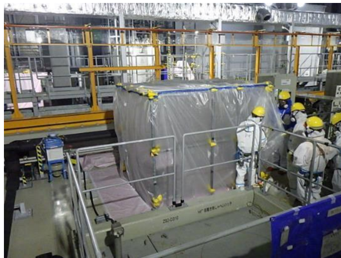
仮設ハウス外観
