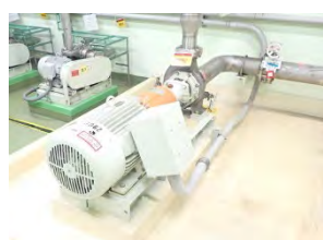
一次冷却水予備ポンプ
