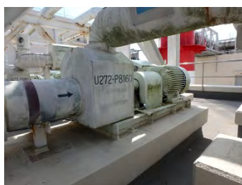
二次冷却水ポンプ
