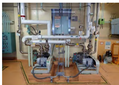
槽類換気系排風機
