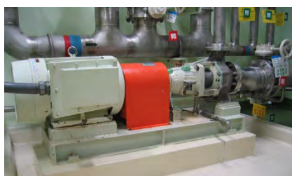
一次冷却水ポンプ
