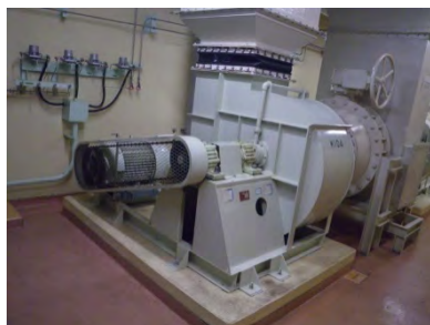
建家換気系排風機
