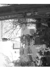
トローラから溶融炉の吊上げ
