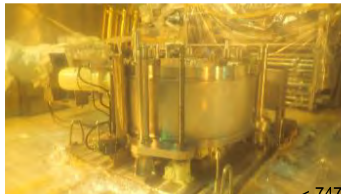
遠隔交換装置全景
