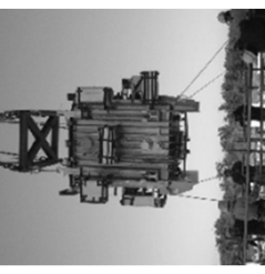
溶融炉架台の設置
