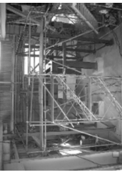
溶融炉架台の設置
