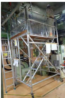
セル内へのケーブル挿入作業
