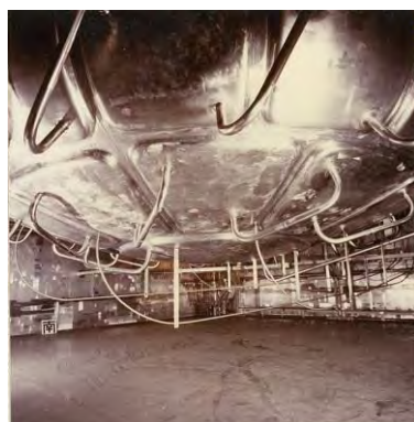
高放射性廃液貯槽(V34) 下部
