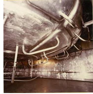
高放射性廃液貯槽（V31）下部
