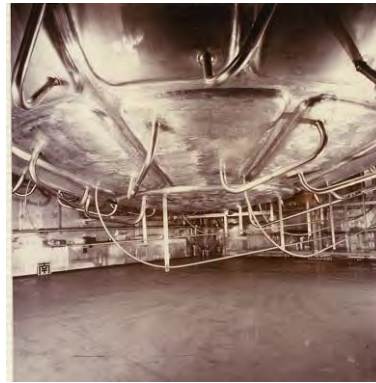
高放射性廃液貯槽 (V35) 下部
