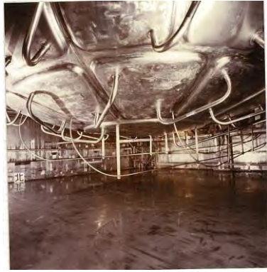
高放射性廃液貯槽 (V33) 下部
