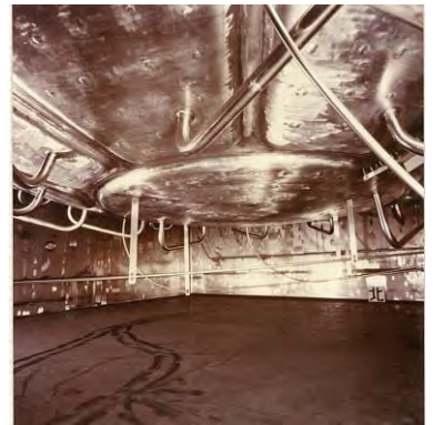
高放射性廃液貯槽(V32) 下部
