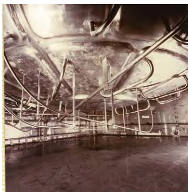
高放射性廃液貯槽 (V36) 下部
