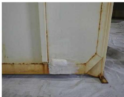
図1. 腐食箇所の補修箇所
