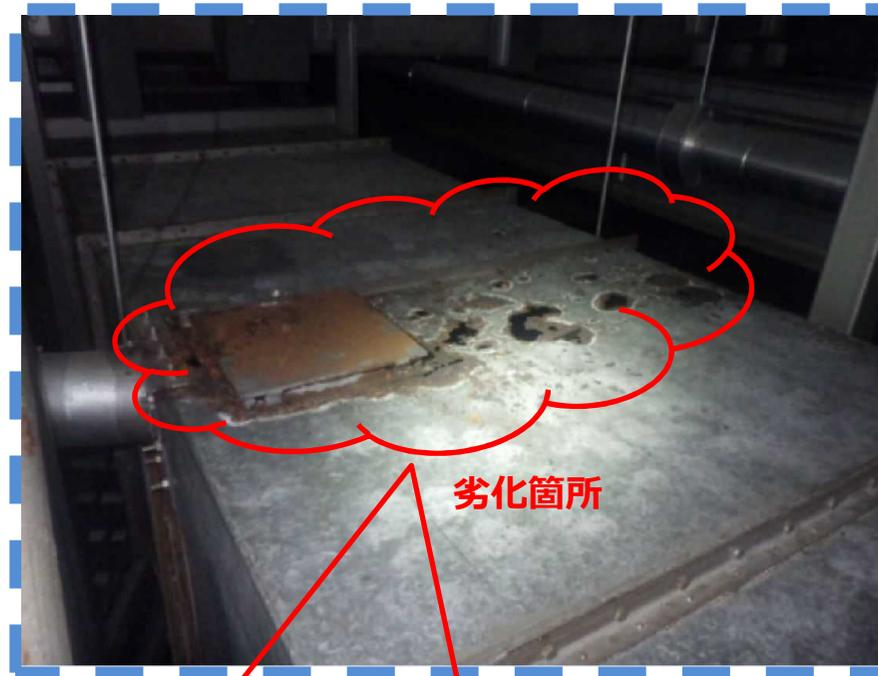
事故時にウェル内からダクトへ、水酸化セシウムを含んだ蒸気が流入したものと推測。亜鉛メッキが高温蒸気を受けた影響やダクトのアルカリ腐食等が考えられる。
