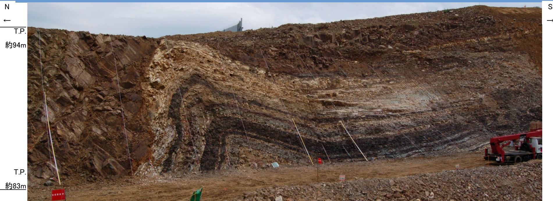
現地写真(新規掘削法面における過褶曲構造) 平成27年10月撮影
