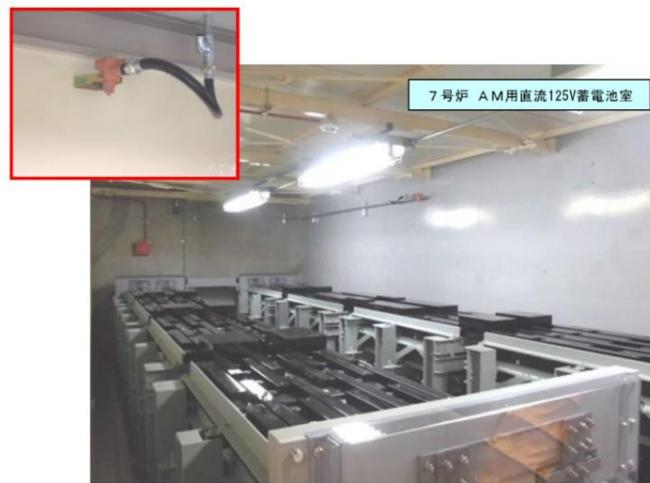
第 41-1-4 図：蓄電池室内の水素濃度検出器設置状況
