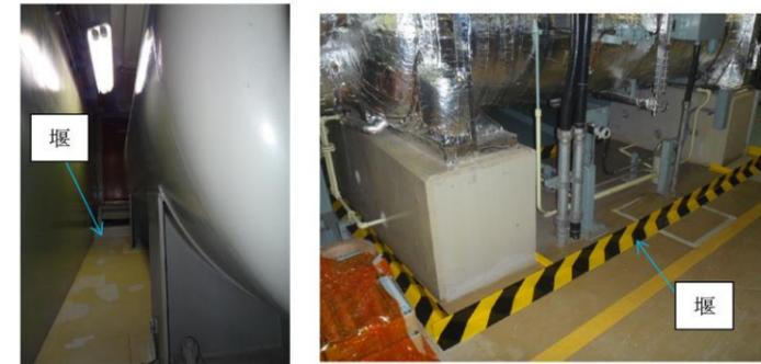
第41-1-2図 堰による漏えい拡大防止対策概要図
