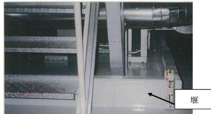
第 41-1-2 図 堰による拡大防止対策の例 (1/2)
