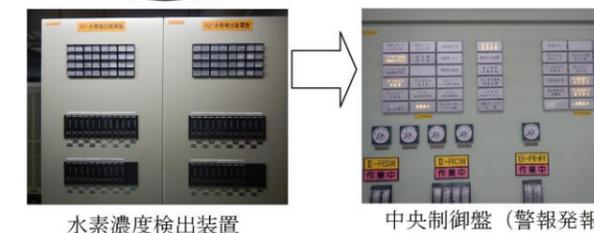
第 41-1-4 図 蓄電池室内の水素濃度検知器の設置状況
