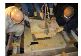
気相部耐火レンガの据付
