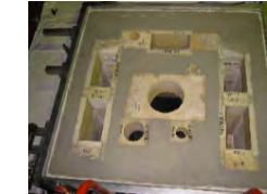
断熱キャストブルの施工
