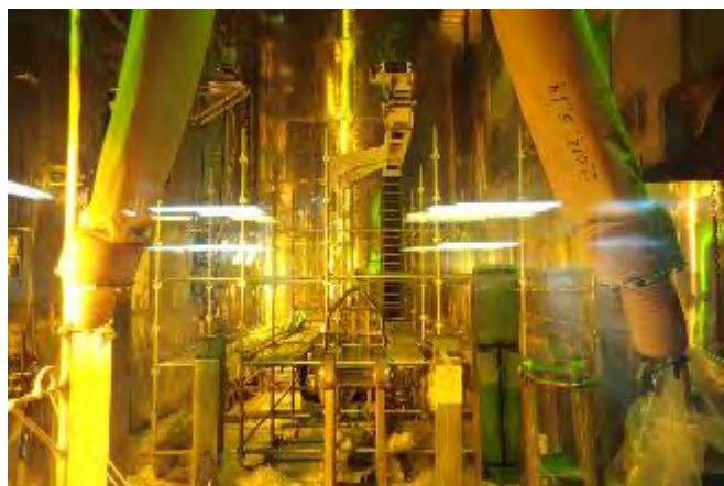
① 既設走行ケーブルリールとの取り合い位置確認(3次元計測)に向けた足場設置(除染セル)
