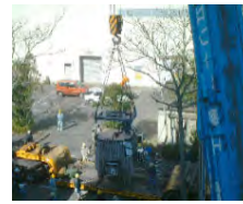
トレーラから溶融炉の吊上げ
