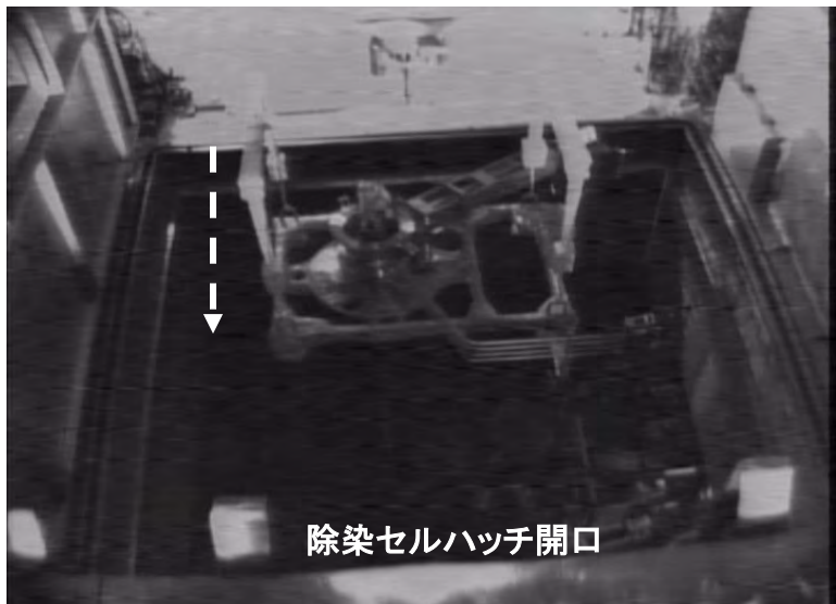
新規結合装置の除染セルから固化セルへの搬入状況
