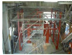
溶融炉架台の設置
