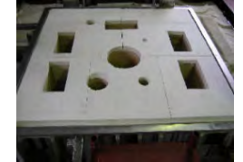
断熱膨張吸収材の施工
