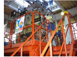
架台への溶融炉据付
