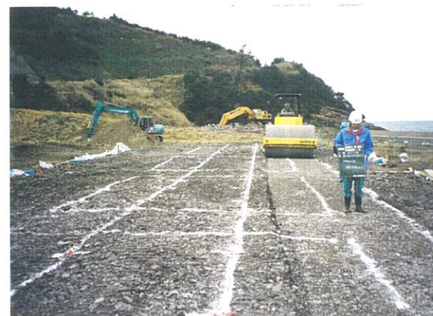
振動ローラによる転圧状況
