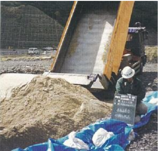
埋戻土(購入土) 現地写真(H11年)
