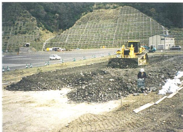
巻き出し整地状況
