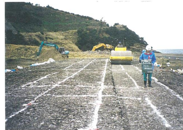
振動ローラによる転圧状況
