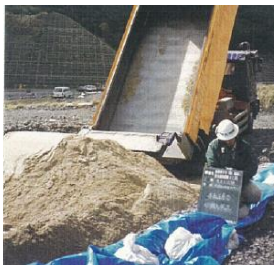
埋戻土(購入土) 現地写真(H11年)
