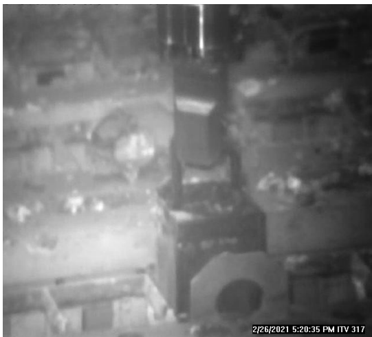
3号機での燃料の吊り上げ（566体目）
