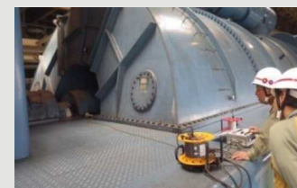
若手保守員の火力研修 タービンロータ振動測定
