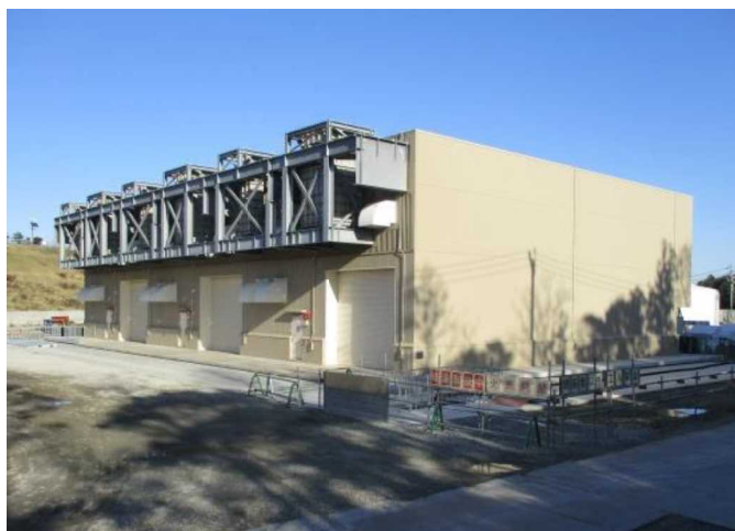
緊急時ガスタービン発電機建屋
