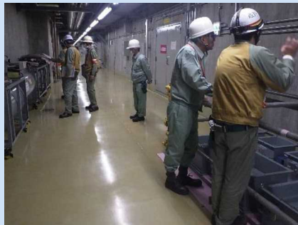
委員による現場確認
