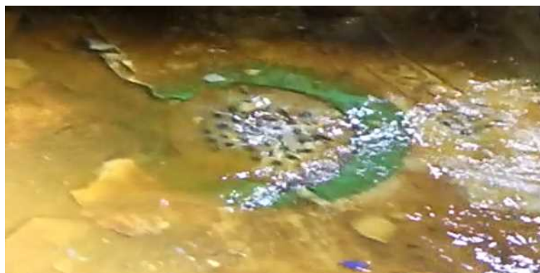
床ファンネル（清掃後）
