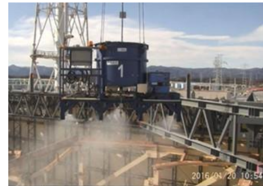
飛散防止剤散布状況
