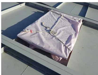
天板点検口（蓋なし、養生実施）
