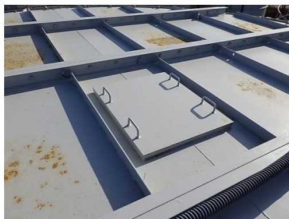
天板点検口（蓋あり）
