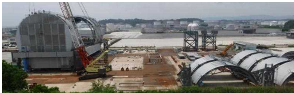
小名浜港でドーム屋根設置訓練状況
