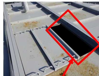
天板点検口（3枚蓋、蓋なし、養生前）
