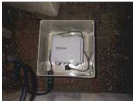
① 1階レベル (北西側構台下)
